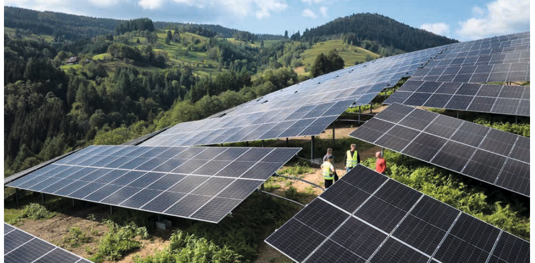
Auf einem Hangstück mit durchschnittlich 32° Neigung entstand 2024 hoch über dem Wiesental der vielleicht steilste Solarpark Deutschlands. Die EWS Schönau produzieren hier Ökostrom für rund 1.550 Haushalte.
