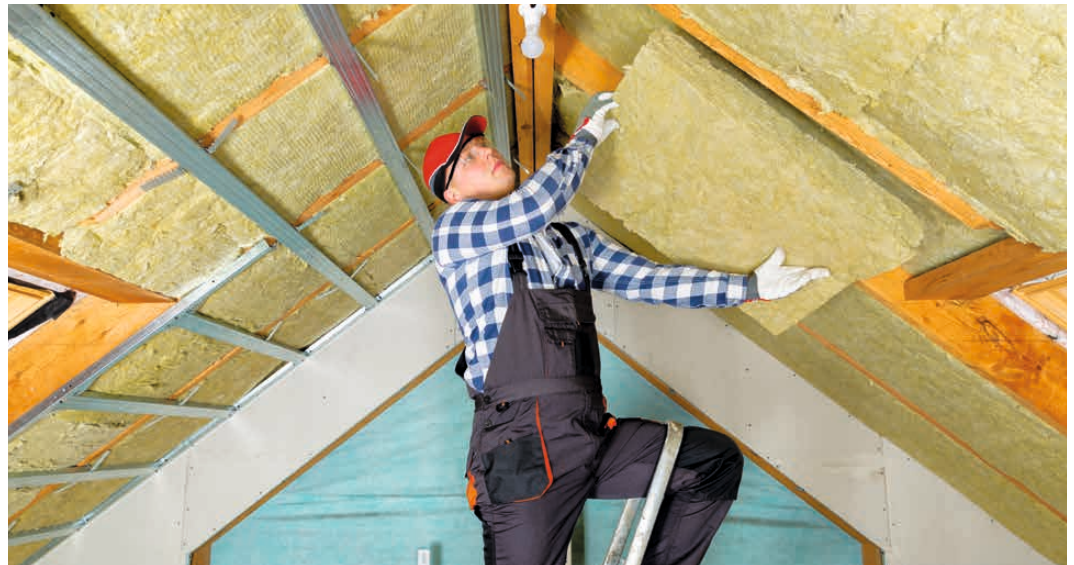
Fachgerecht dämmen für mehr Energieeffizienz: Eine Dachsanierung mit moderner Zwischensparrendämmung senkt Wärmeverluste und steigert den Wohnkomfort nachhaltig.
