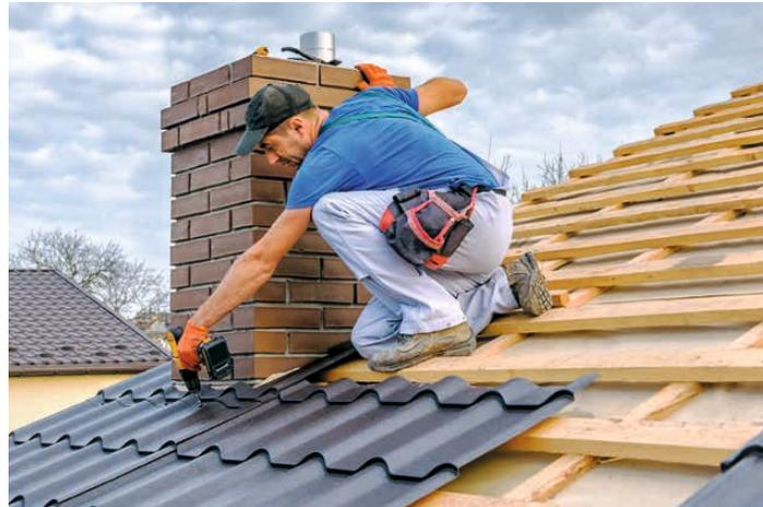
Ein Dachhandwerker bei der Sanierung einer geneigten Dachfläche: Die neue Lattung ist vorbereitet, die modernen Dachsteine werden passgenau eingedeckt.
