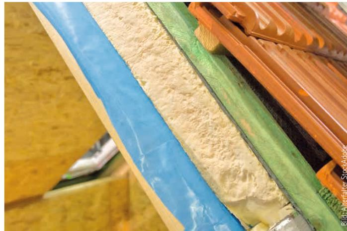
Ein Querschnitt durch die Dachkonstruktion: Deutlich zu erkennen sind die Wärmedämmung, die Unterspannbahn und die Dachziegel. Diese Kombination sorgt für eine optimale Energieeffizienz.
