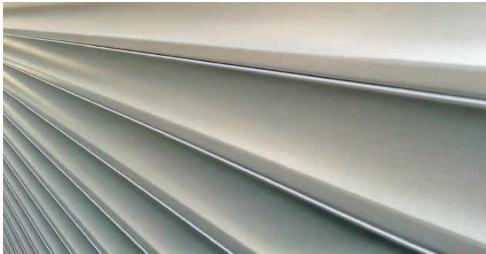
Raffstoren sind funktionale Sonnen- und Sichtschutzsysteme, die an Fenstern montiert werden und durch ihre verstellbaren Lamellen aus Aluminium eine flexible Regulierung des Tageslichts ermöglichen. Diese Systeme sind besonders robust gestaltet, um selbst extremen Wetterbedingungen wie starkem Regen, Hagel und Wind standhalten zu können. Die Hauptfunktion von Raffstoren
