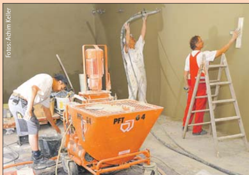
Kellersanierung: Trocken, schimmelfrei und vielseitig nutzbarer Raum.
